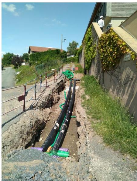
Travaux du réseau de chaleur de Montrottier
