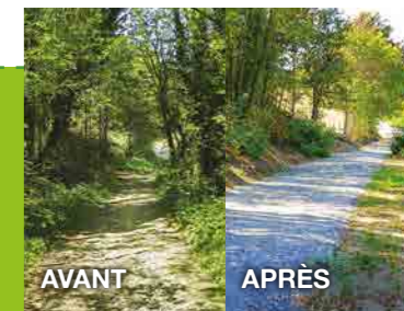
AMÉNAGEMENT DU MASSIF DU CHATELARD À AVEIZE amélioration de 4 km de pistes, création d'une route forestière et de 2 places de dépôts pour pouvoir stocker le bois.
