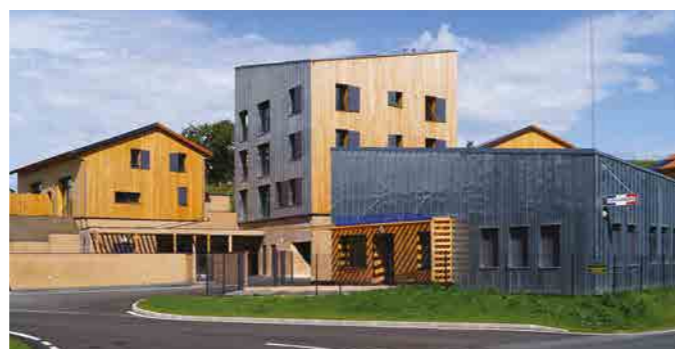
La nouvelle gendarmerie, située à St Symphorien sur Coise, a été réalisée par la Communauté de communes avec le souci d'en faire un bâtiment exemplaire, à énergie positive et à faible empreinte carbone. Ce bâtiment se caractérise par sa sobriété en matière énergétique intégrée dans sa conception (isolation renforcée, LED, puits de lumière, brise soleil...). Également, l'installation en toiture de panneaux photovoltaïques et panneaux solaires thermiques permet la production d'énergies renouvelables.
