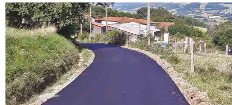
Travaux réalisés en 2018 à Souzy
