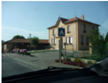
Mairie sans parvis ni place publique, une partie du parking ne pourrait-elle être laissée à l'accueil des habitants? Coise
