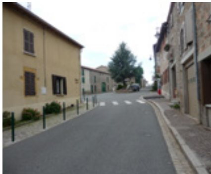
Réduction de la largeur de la voirie pour l'ajout d'un trottoir en bande pavée délimité par des potelets, Longessaigne
