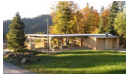
Abri-refuge de la Borne au Lion, la Pesse. Création d'un bâtiment d'accueil et réorganisation de stationnements pour site naturel historique, (39). Crédit photo : Atelier Archi&Design
